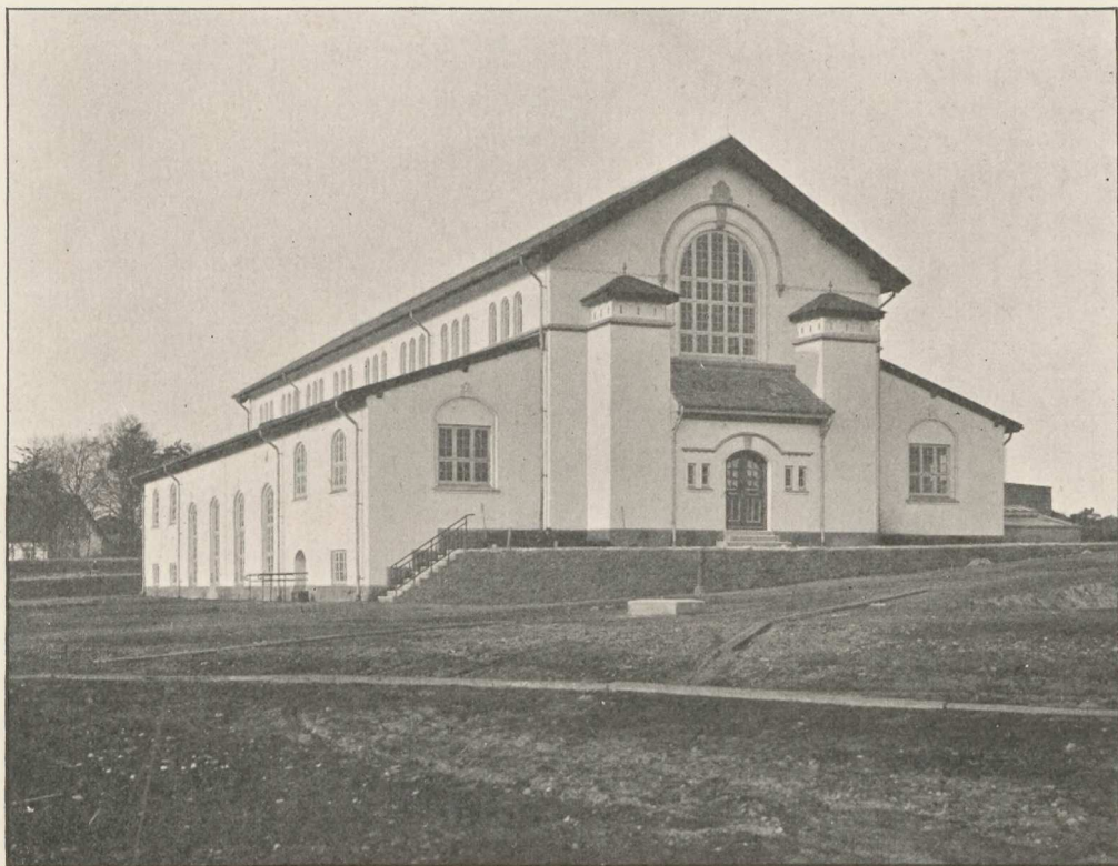
Maskinbygningen ved Thorsbro.
