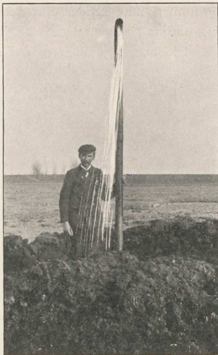
Undersøgelsesboring ved Ishøj.
