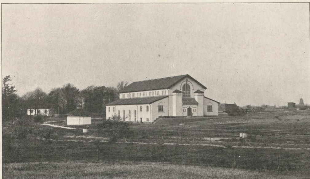
Vandværkspladsen ved Thorsbro.
