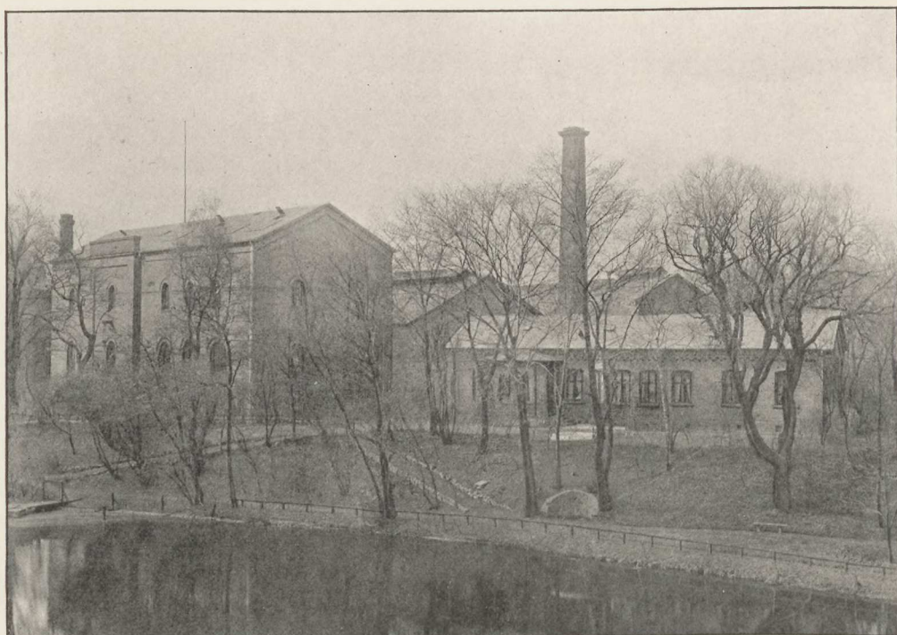
Værket ved Vesterfarimagsgade set fra Aborreparken.
