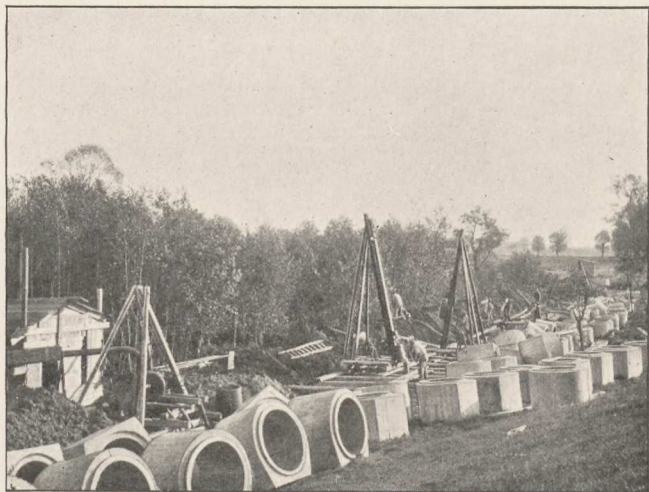
Betonledningen Thorslunde—Thorsbro under Udførelsen.
