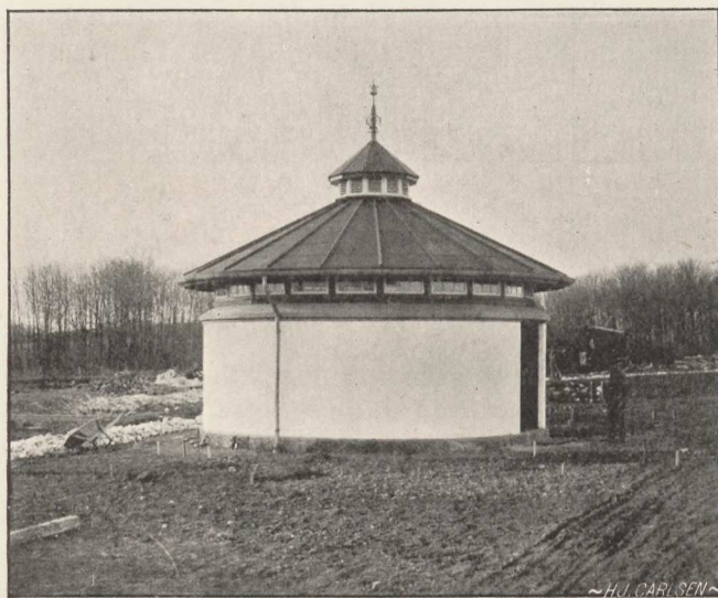
Overbygning over Samlebrønden.
