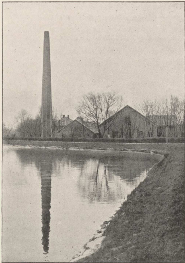
Pumpestationen ved Gl. Kongevej.
