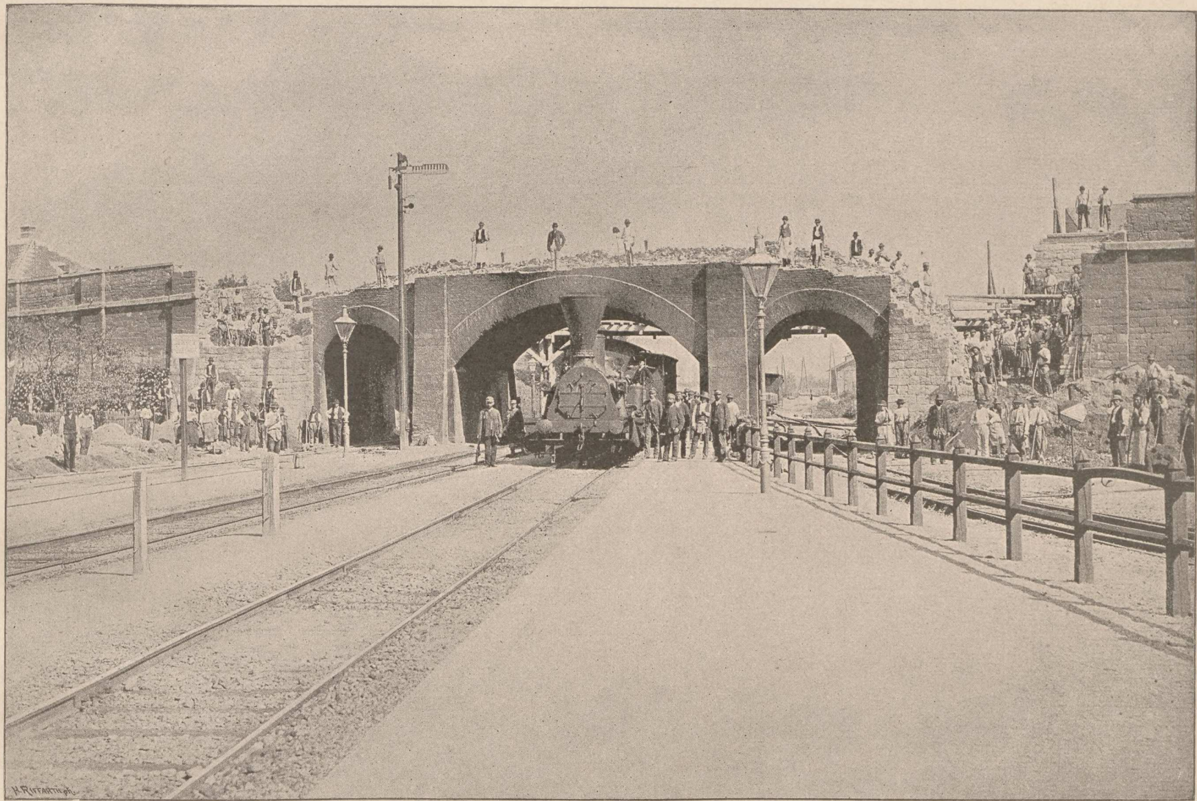
Abbruch der alten gemauerten Bahnüberführung auf Station Mödling bei Wien.
