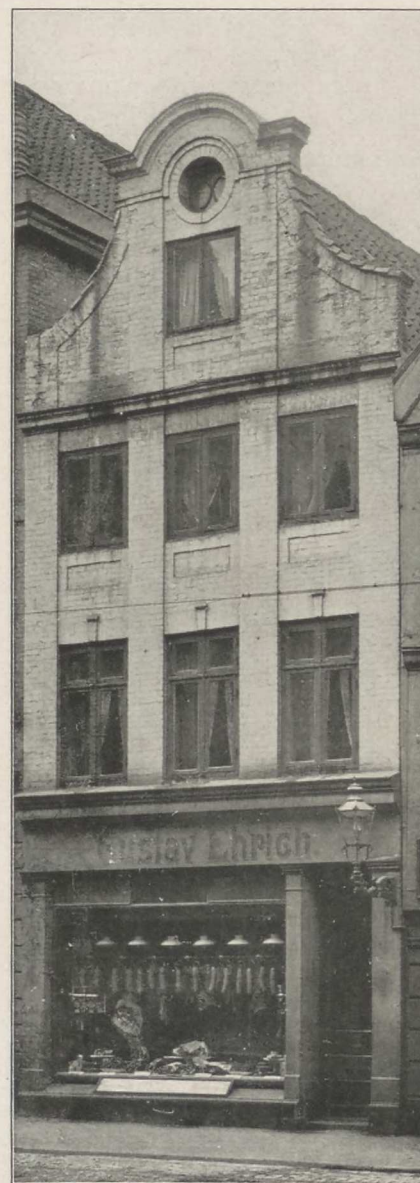
Holstenstrasse 44, nu nedrevet.
