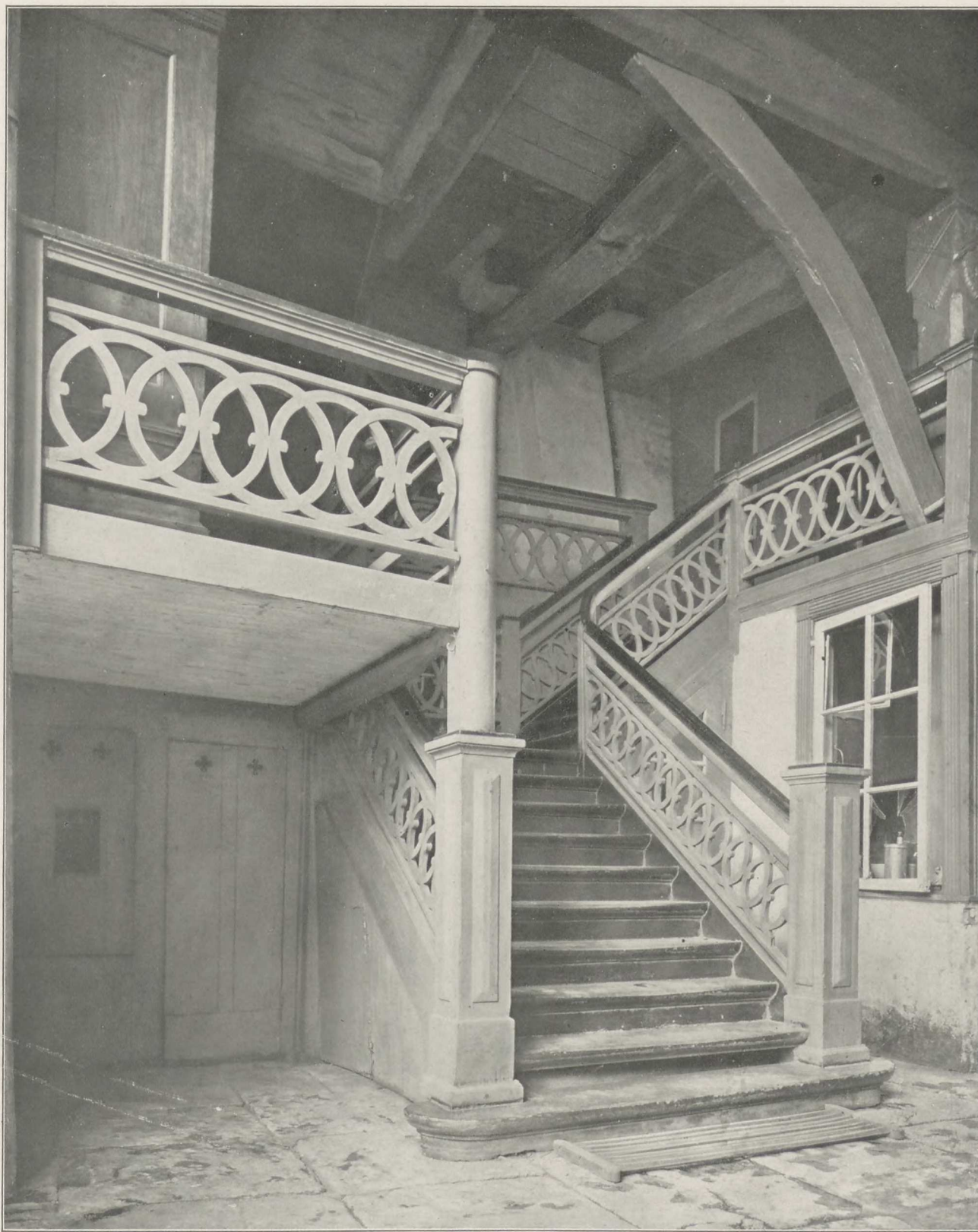
Hovedtrappe, Wahmstrasse 37, Lübeck.
