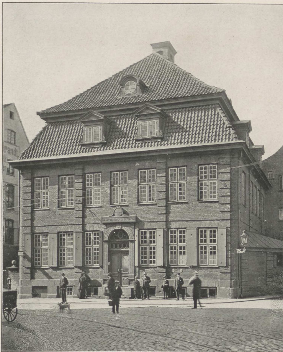
Das Schweißelhaus, 1775, Kiel. Nu nedrevet.
