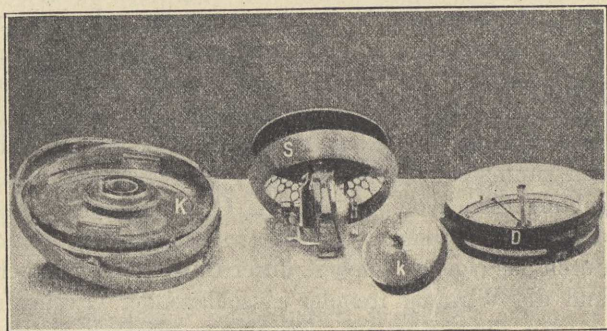
Fig. 50. Teile des Kreiselkompaß.
