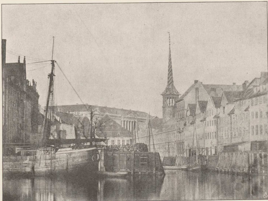
Kanal bag Børsen, hvor nu Slotsholmsgade er.
