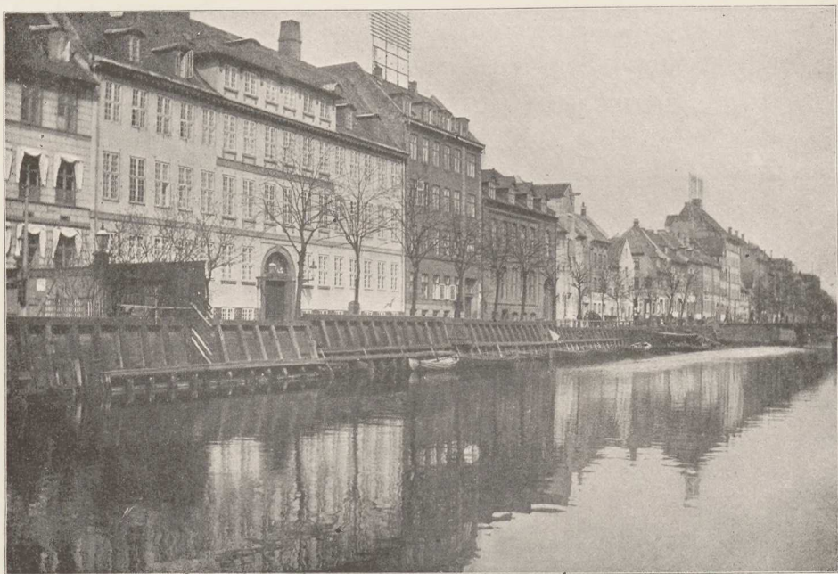
Christianshavns Kanal ved den Heeringske Gaard.
