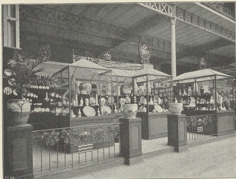
Den Kgl. Porcelainsfabrik.
