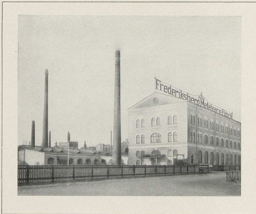
Den nye Fabrik. Udvidelsen mod Nitivej.
