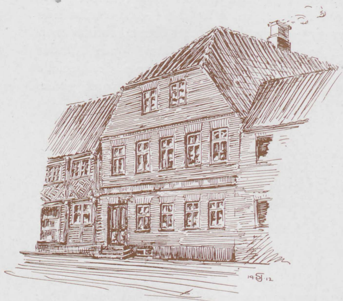
A. H. Iversens gamle Hus paa Helligkorsgade.
