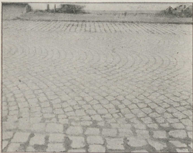
Fig. 44. Chaussébro'ægning med halvkredsformet Forbandt.
