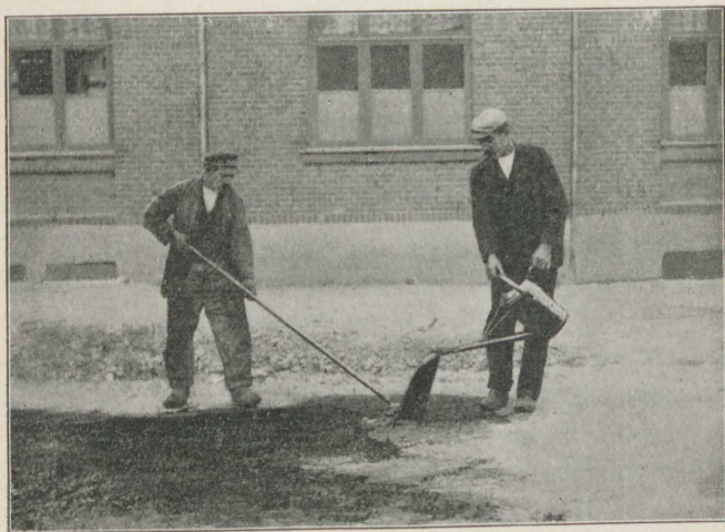
Fig. 6. Overtjæring med Kande.
