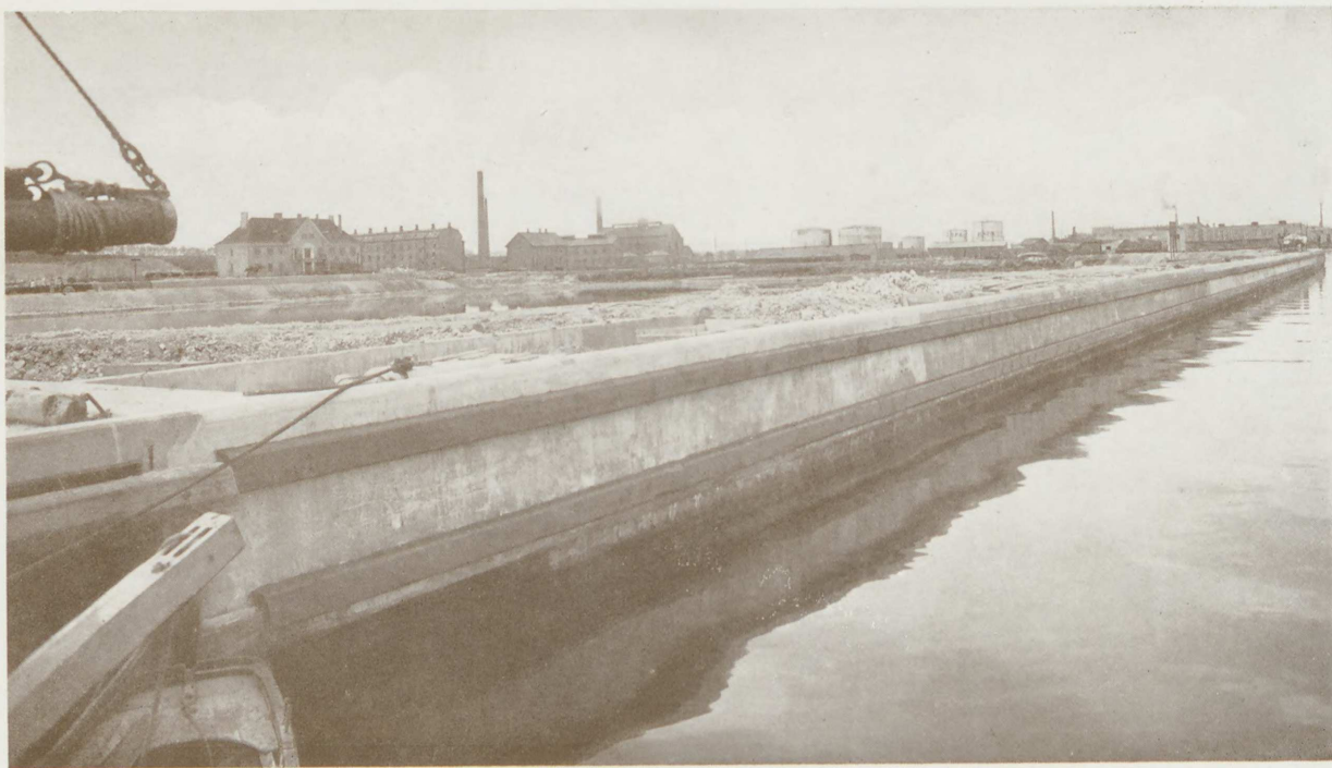
BOLVÆRK VED AALBORG, DANMARK.
