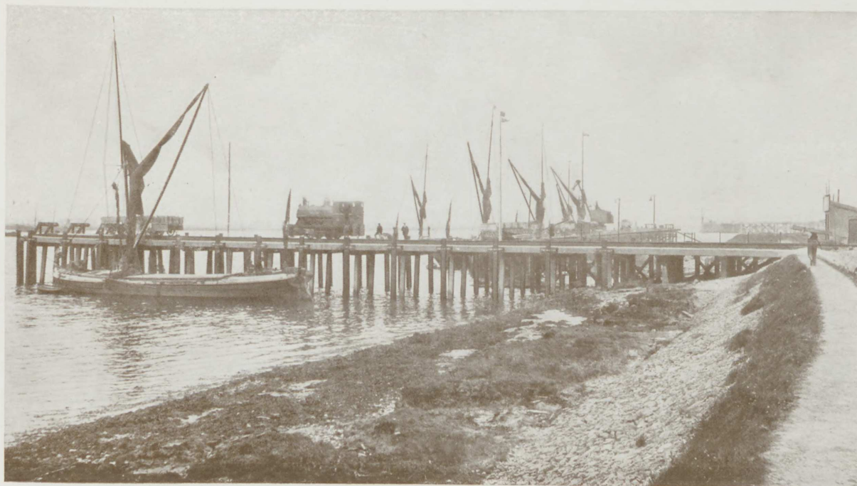
ANLÆGSBRO VED GRAYS, ESSEX, ENGLAND.
