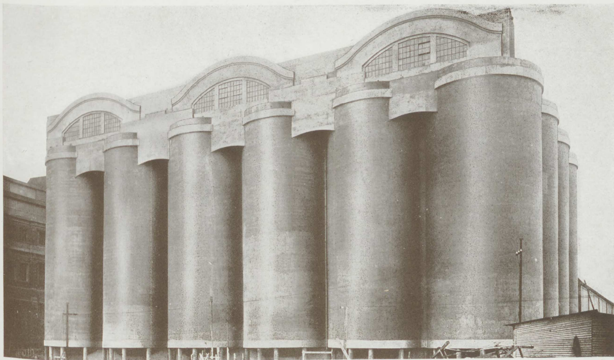
SILOER. 9 m. Diameter, 27 m. Højde.
