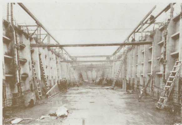
1000 TONS KULBAADE UNDER BYGNING. Siderne løftes.
