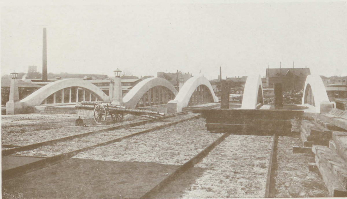
BRO OVER VARDEAA VED VARDE, DANMARK.
