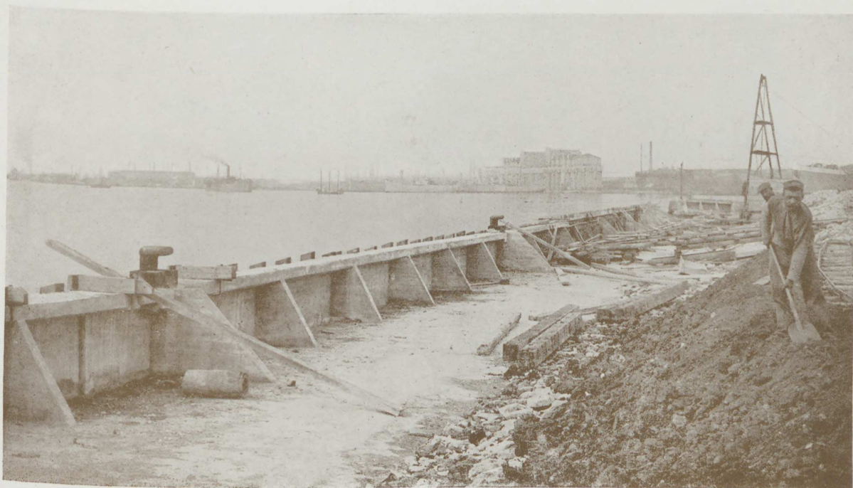
BOLVÆRKSARBEJDER VED NIKOLAJEFF, RUSLAND.
