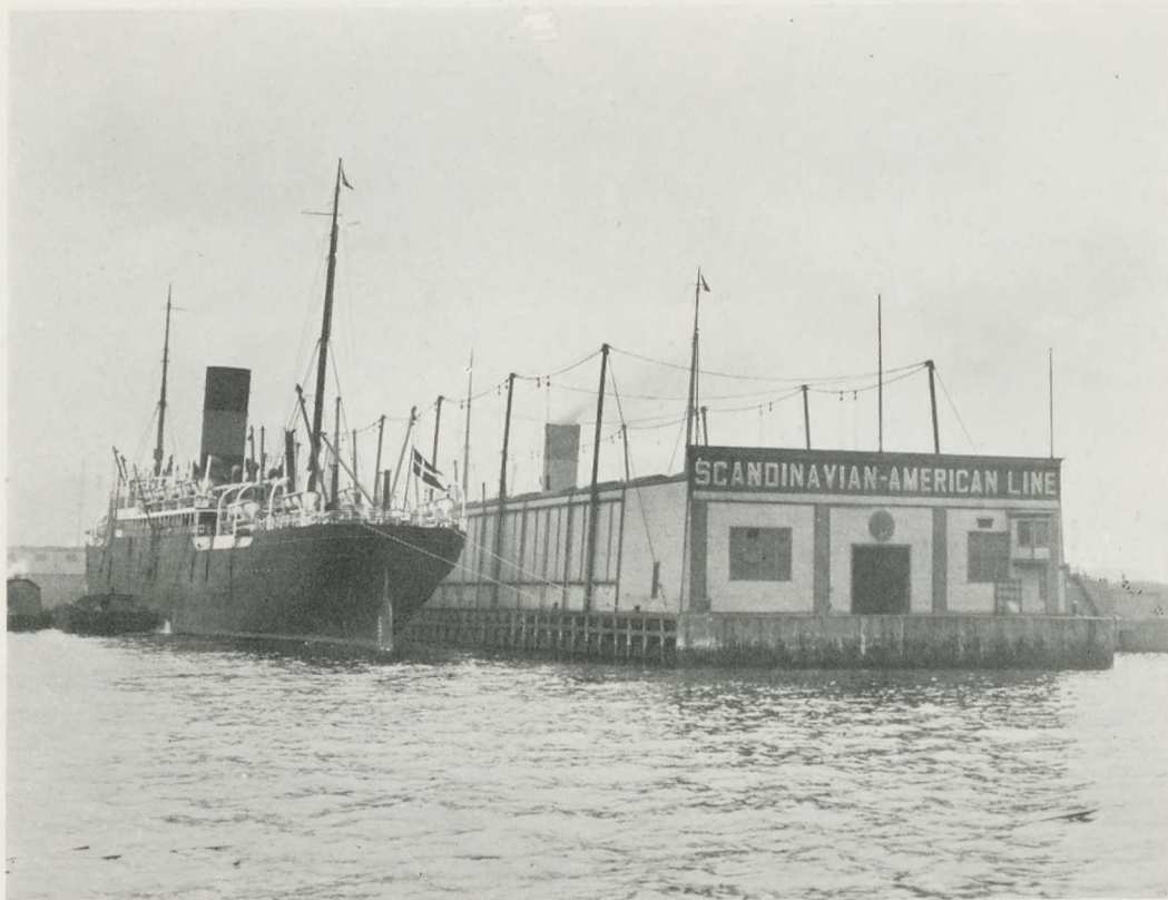
Amerikabaadene ved Anlægspladsen i New York.
