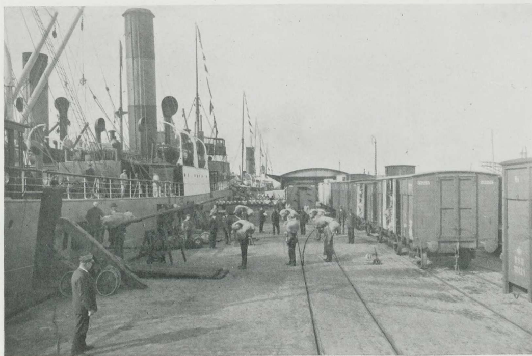
Indladning i Esbjerg.
