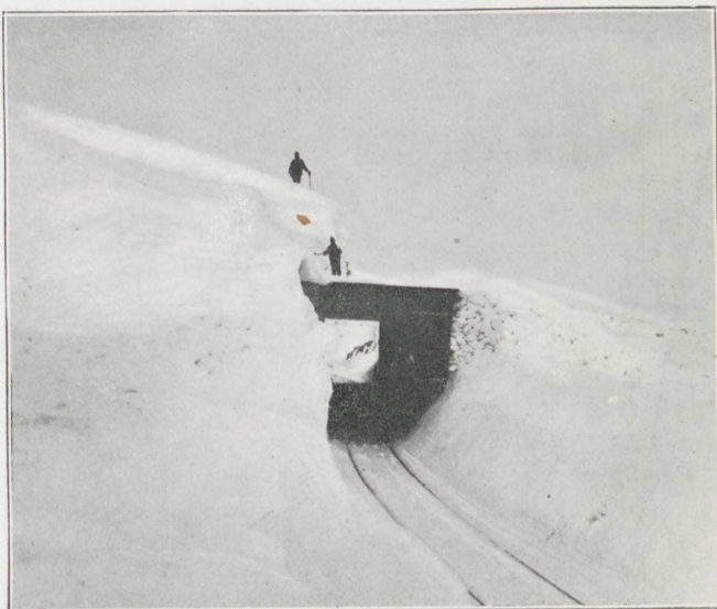
Fot. 7. INDBYGNING KM. 41.10, APRIL 1903.
