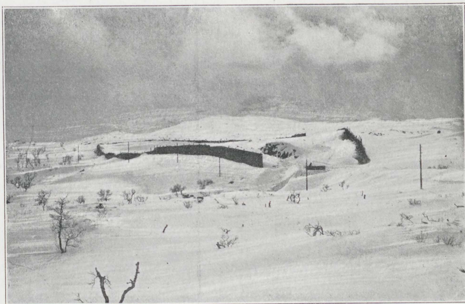
Fot. 3. SNESKJÆRME VED KM. 35.80, APRIL 1903.
