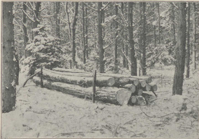
Fig. 29. 1 Bk. Klodstræ af Skovfyr (§ 11, Litra g). Ydre Maal: H = 0.60 m, B = 1.00 m, L = 5.00 m.
