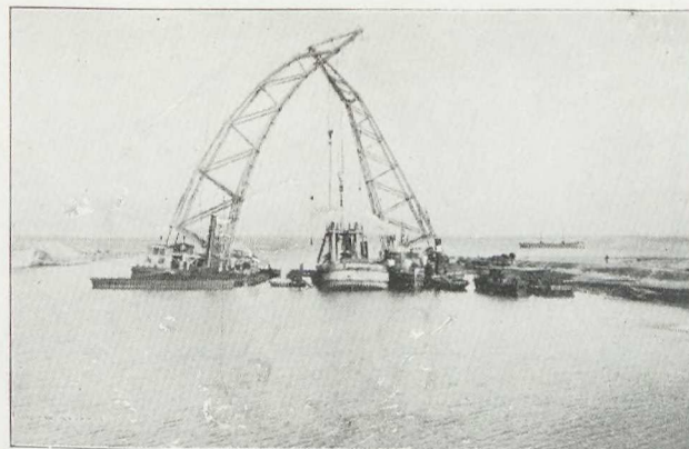
Fig. 15. Bjærgning af den havarede Uddybningsmaskine.
