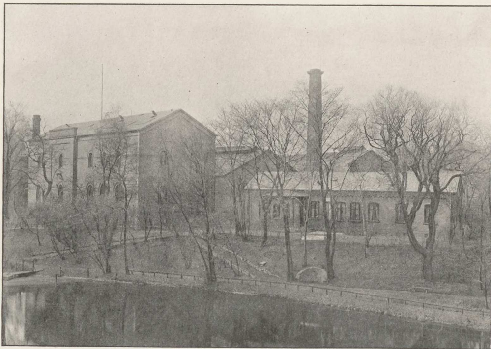
Værket ved Vesterfarimagsgade set fra Aborreparken.
