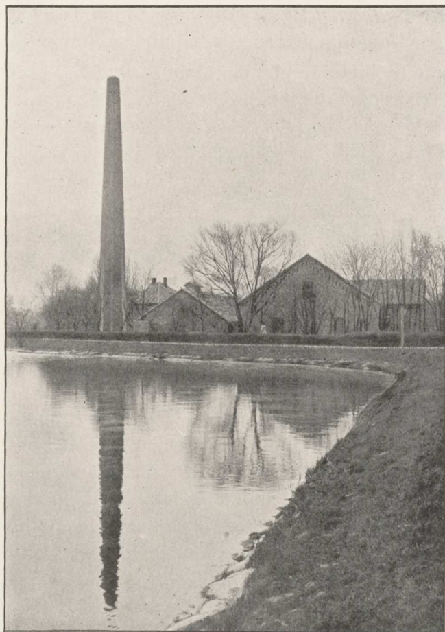
Pumpestationen ved Gl. Kongevej.
