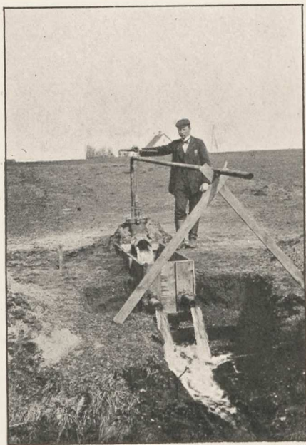
Undersøgelsesboring ved Solhøj Huse.
