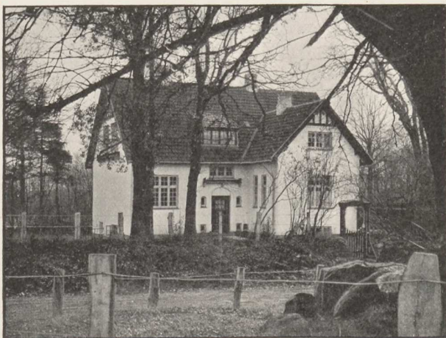
Funktionærbolig paa Værket ved Thorsbro.
