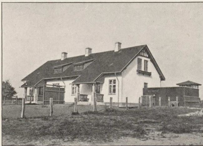
Funktionærbolig paa Værket ved Thorsbro.
