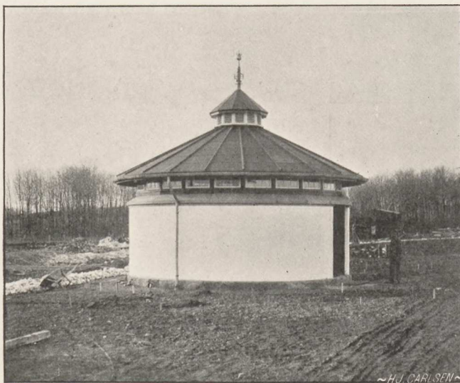
Overbygning over Samlebrønden.
