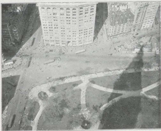
Fig. 28. Madison Square, set fra Metropolitan Tower.
