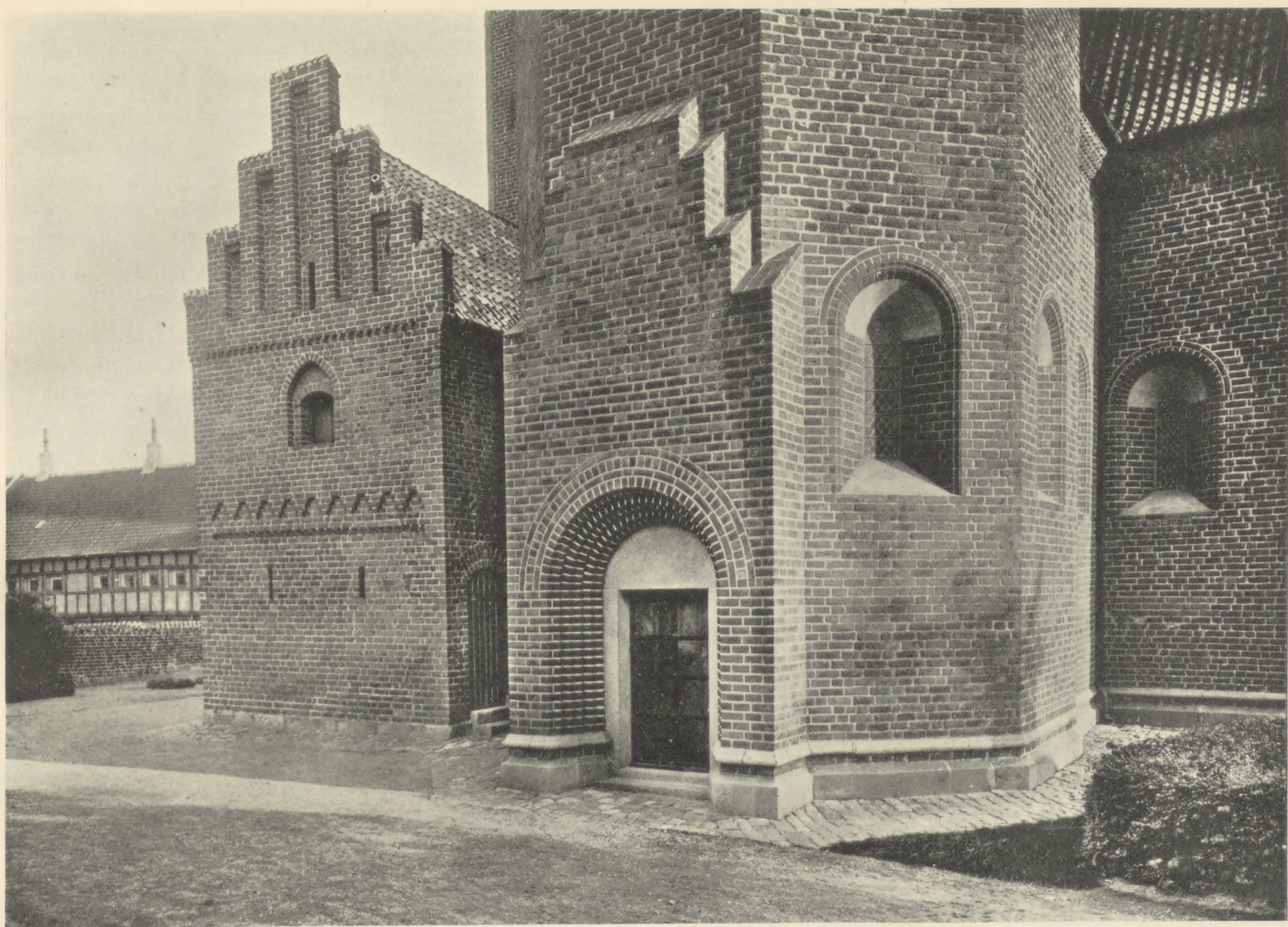
Fig. 10. Nordportal og Gavlf af Sakristi. — Northern entrance and gable of sacristy.
