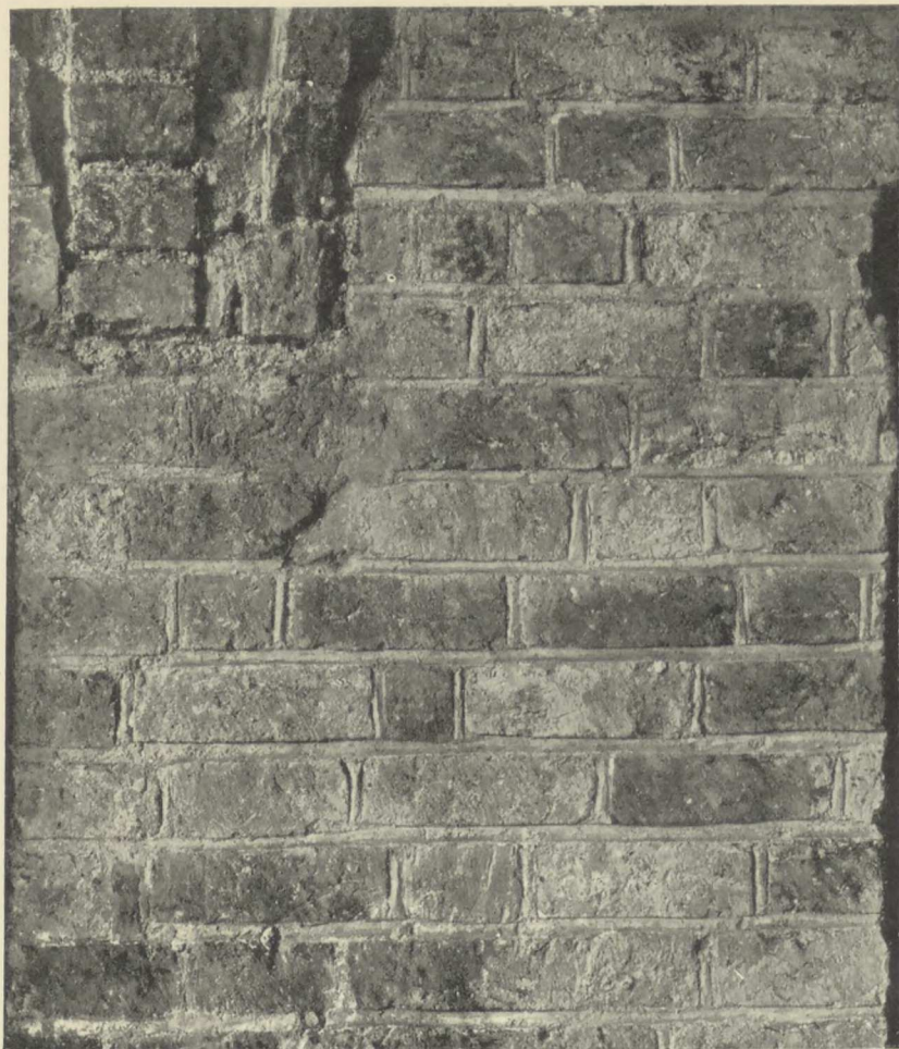
Fig. 8. Oprindeligt Murværk. — Original masonry.
