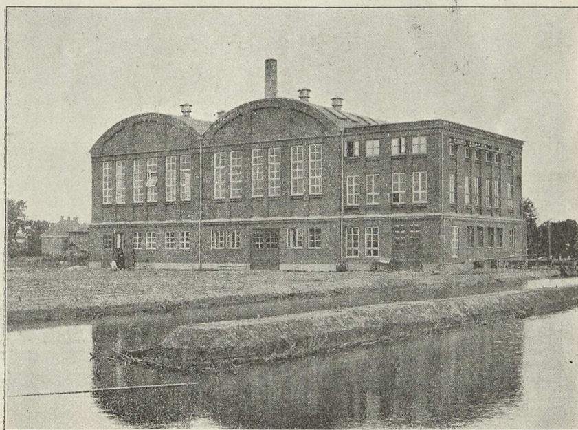
Fig. 2. Damp turbinecentral. (Sydøstsjælland's Elektricitets A/S, Haslev).
