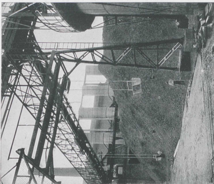
Gjennoptagning av materialet fra lagerpladsen ved hjælp av en Bleichert elektrohængebane. Transportkasserne kan fra en kjørbær bro avsættes eller fylles og bortkøres fra ethvert sted av pladsen.
