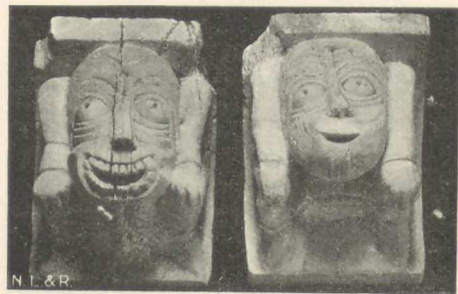
Fig. 88. Tagstøtter under nordvæggen ved Trondhjems domkirkes vinger.
