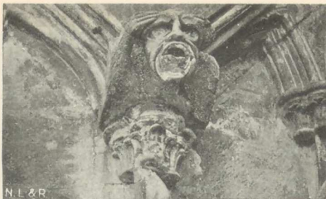
Fig. 286. Vandspy fra ottekantens kleristorium, Trondhjem.
