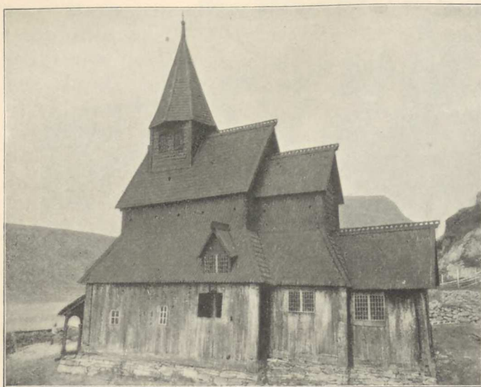
Fig. 32. Urnes kirke. Oppudset i 1907 af arkitekt H. M. Schirmer.
