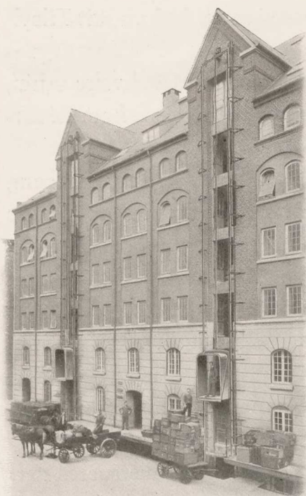
Fællesforeningen for Danmarks Brugsforeninger. 2 udvendige Vareelevatorer à 800 kg med Personledsagelse og Tovstyring.
