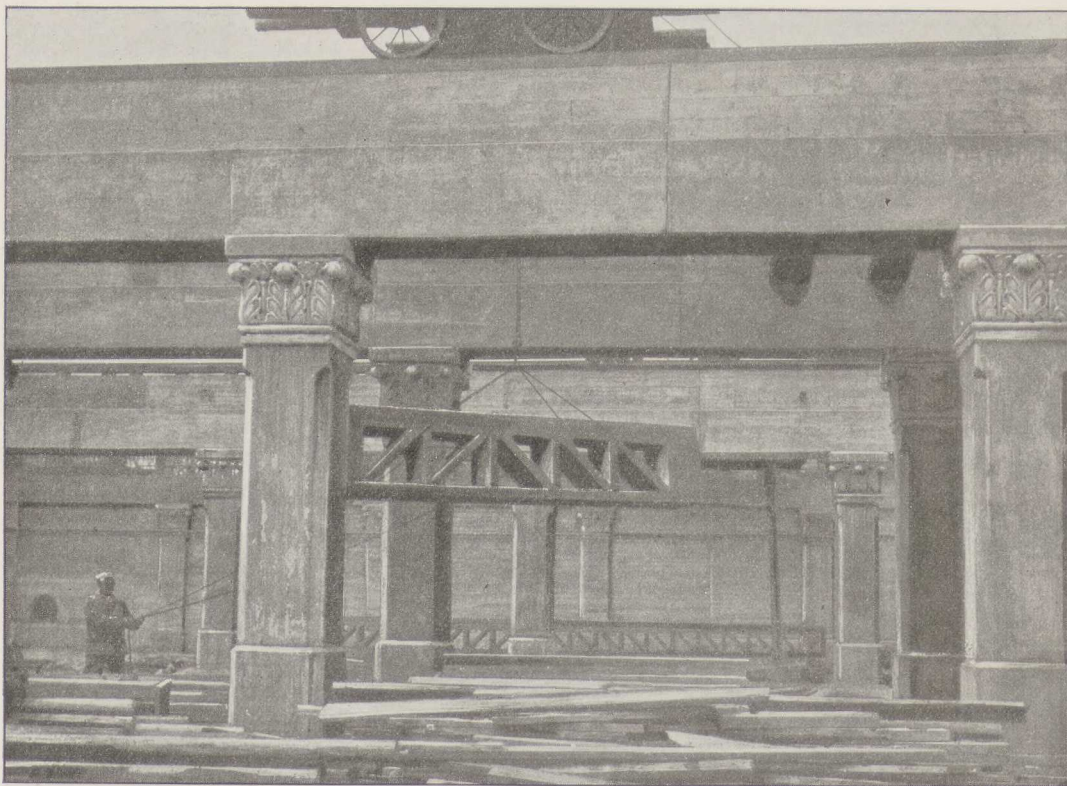
Fig. 73. Viadukten for Østerbrogade. Monteringskran.
