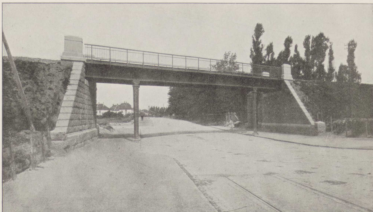
Fig. 88. Viadukten over Remisevej.
