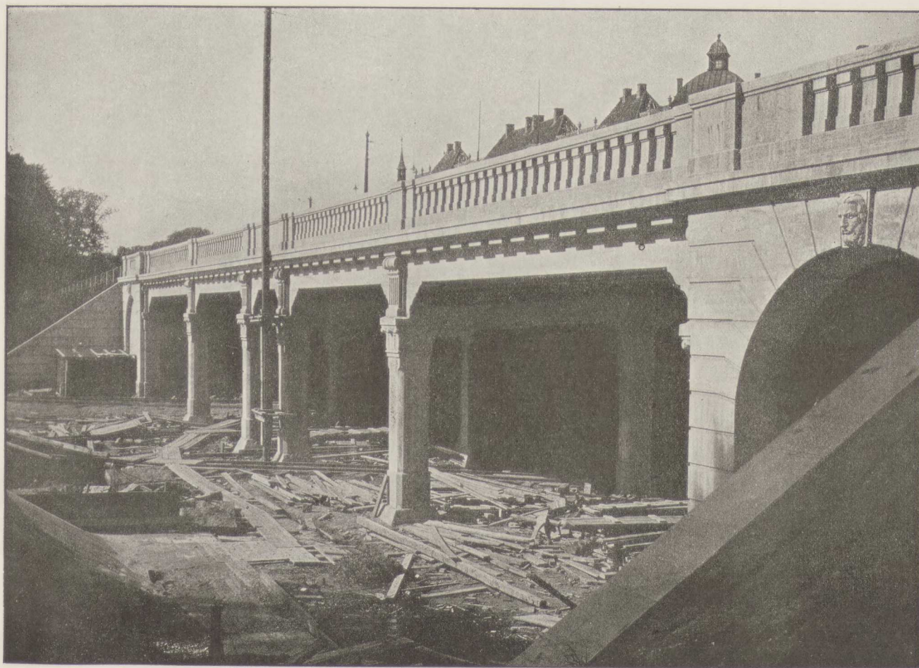
Fig. 72. Viadukten for Østerbrogade.
