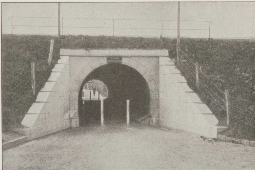
Fig. 50. Fodgængertunnel ved Enghavevej.
