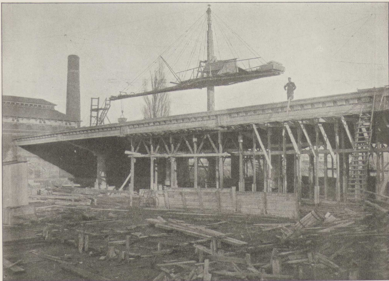
Fig. 37. Tietgensgadeviadukten. Monteringskran.
