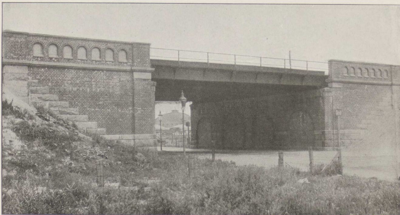
Fig. 76. Viadukt over Øresundsgade.
