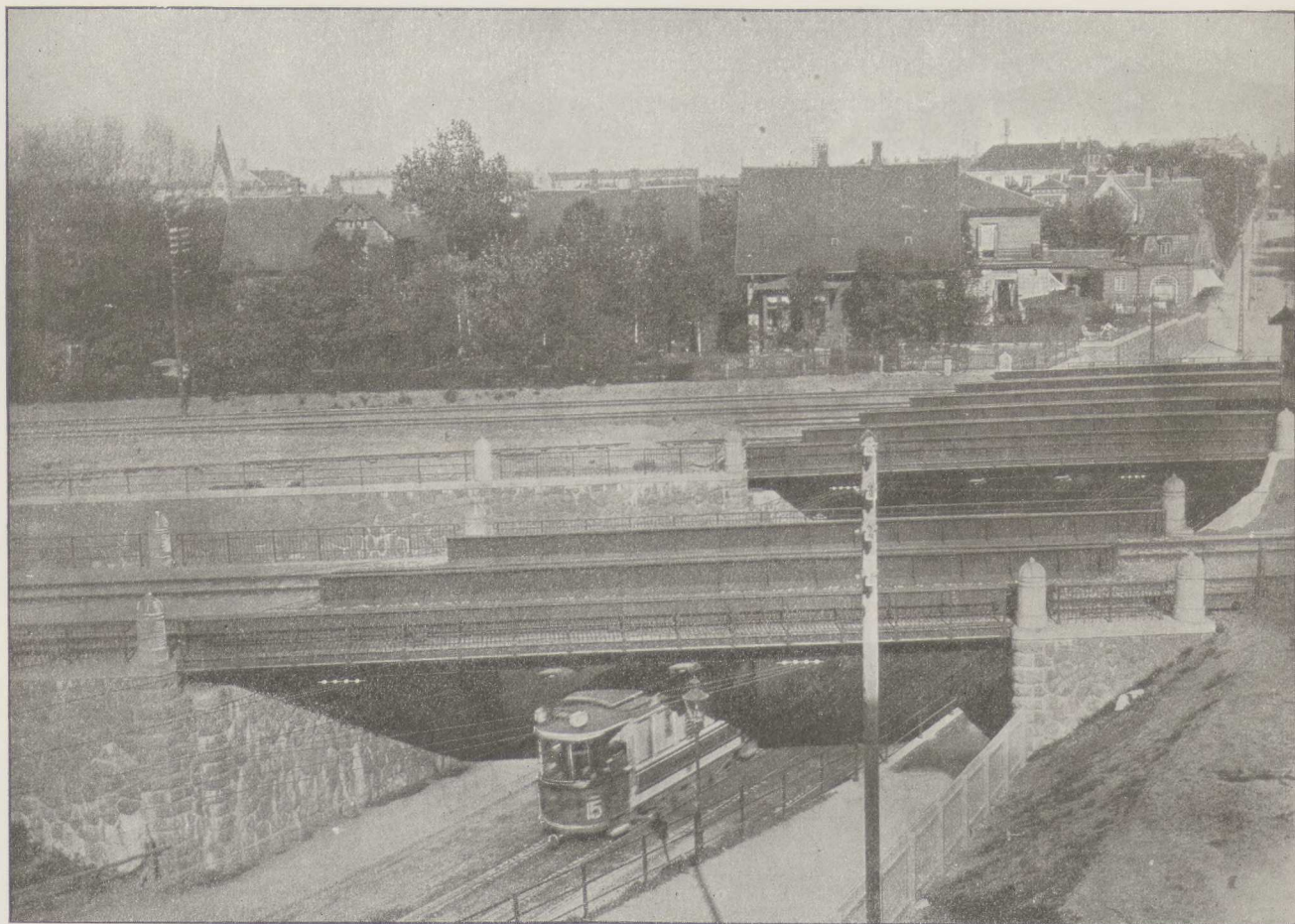
Fig. 82. Viadukten over Hellerupvej.
