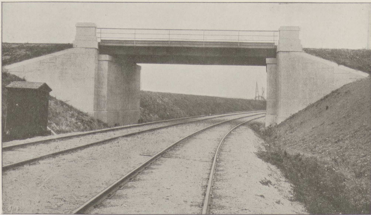
Fig. 96. Den nye Vestbanes Viadukt over Godsbanen.
