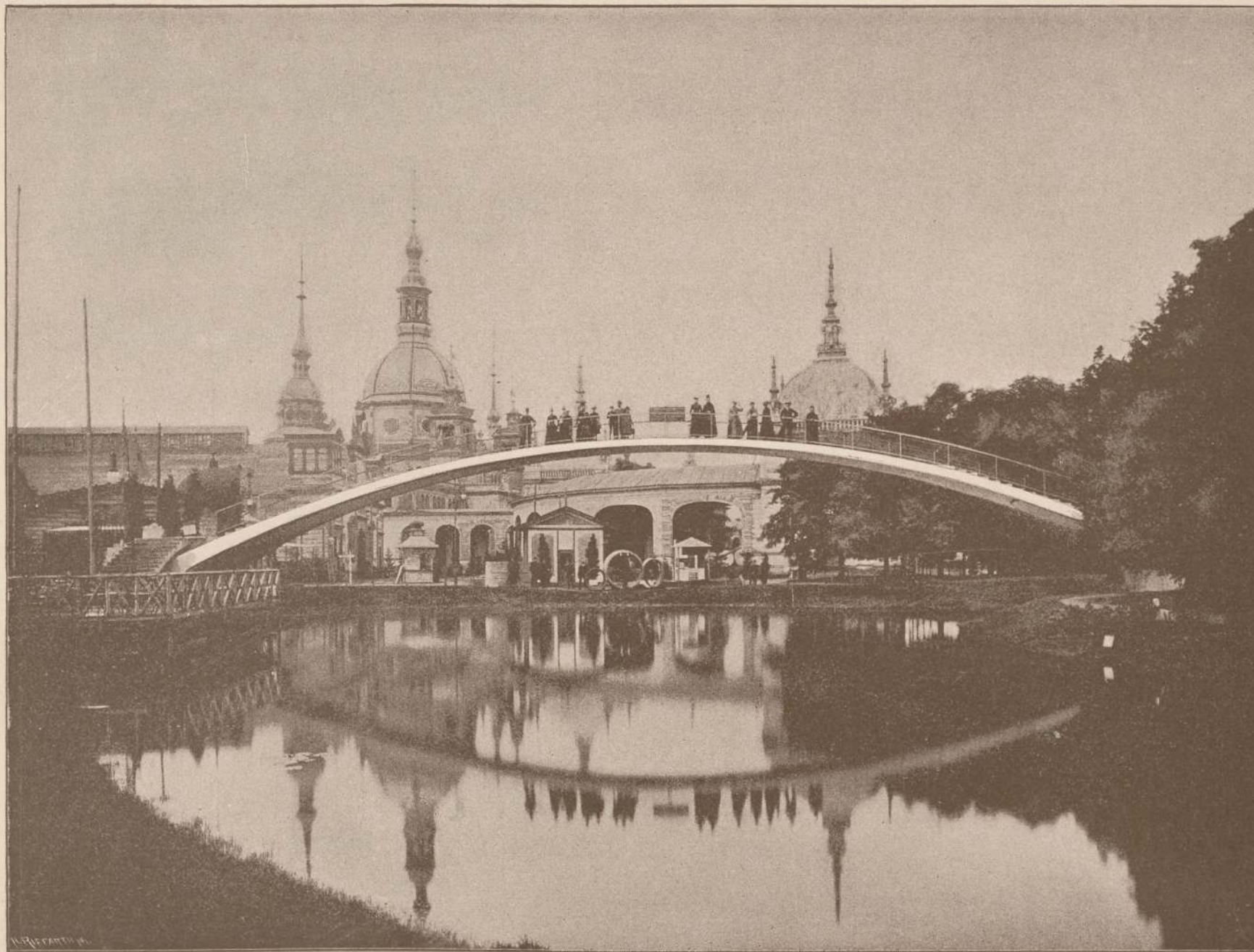
Monierbrücke auf der Nordwestdeutschen Gewerbe- und Industrie-Ausstellung Bremen.
