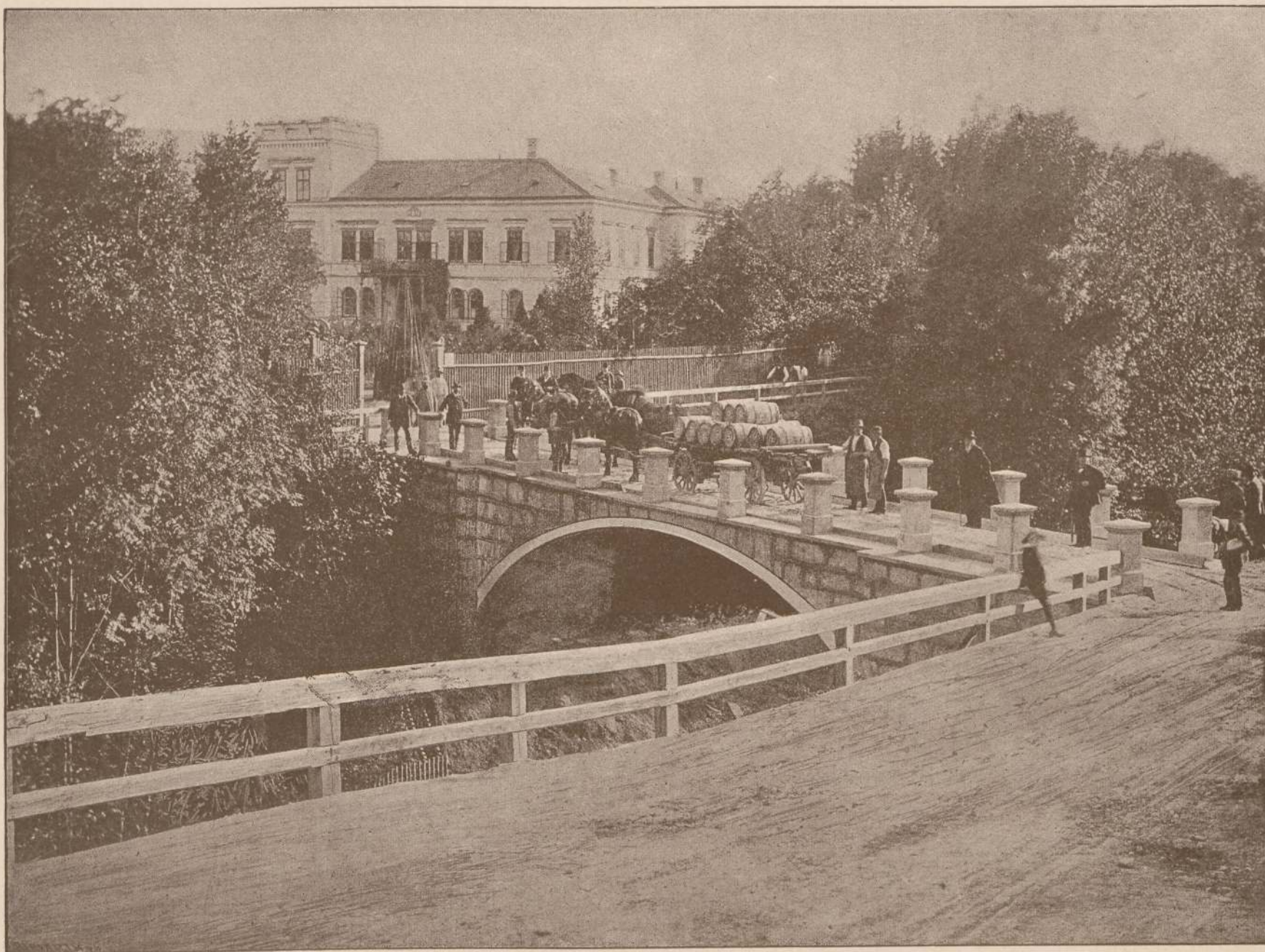
Strassenbrücke nach „System Monier“ zu Steyr (Ober-Oesterreich).
