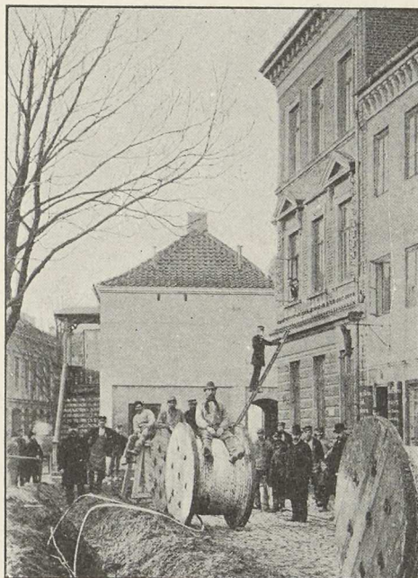
Nedlægning af underjordiske Kabler.
