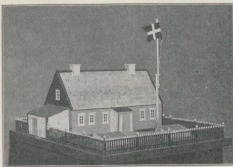
Model af en Inspektørbolig. (Udført af en Grønlænder i Sukkertoppens Distrikt.)
