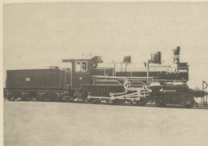
2 C Viercylinder-Verbund-Schnellzug-Lokomotive für die Eisenbahn Madrid-Saragossa-Alicante (1903).
