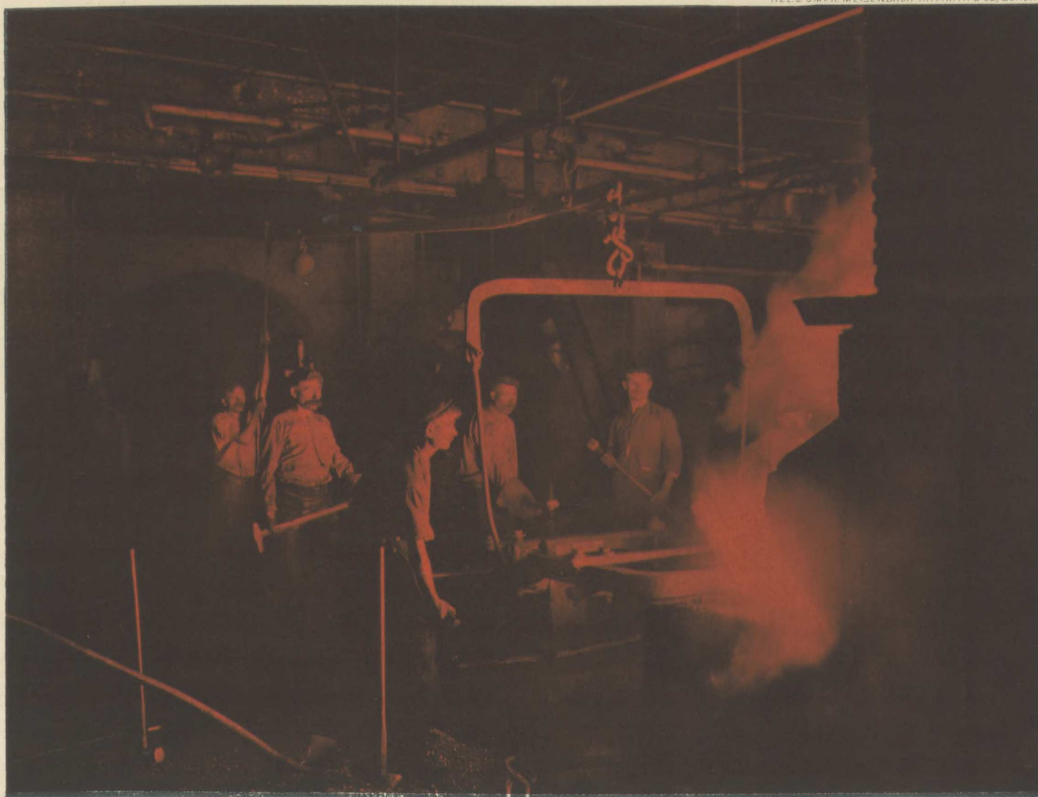
SCHWEISSEN EINES BODENRINGES IN DER HAMMERSCHMIEDE
