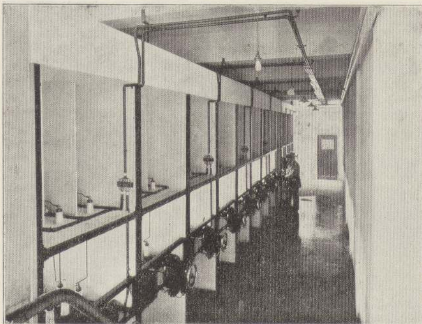
Fig. 12. Olieafbrydere i det sekundære System.
