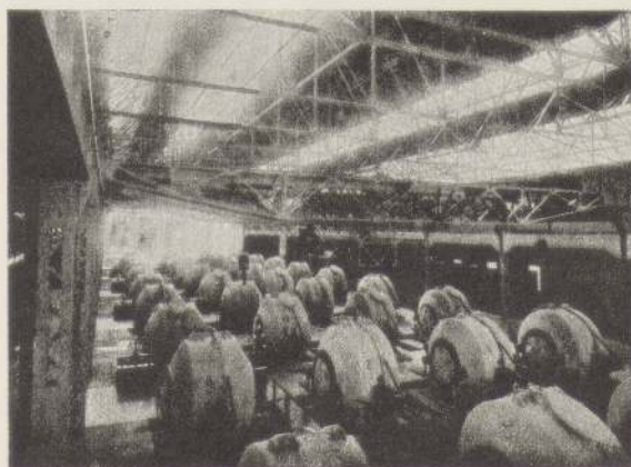
Fig. 14. 4000 kilowatt ovne ved Rjukan II, aar 1915—16.
